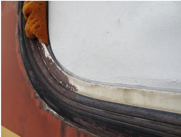
Detalle del sellado exterior de la ventana tapada lado pasillo
