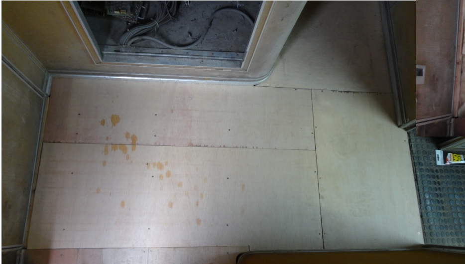
Solado con tableros
